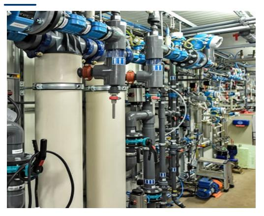
Filtration über eine poröse Membran (Porenweite 0,02 µm)
