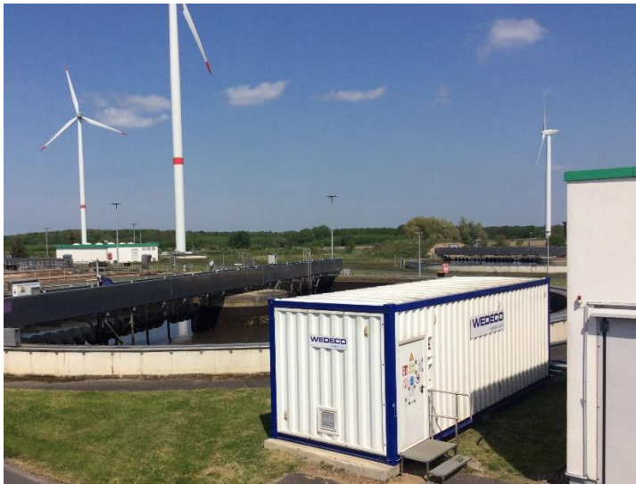
Abbildung 1: Pilotanlage zur Ozonung, Klärwerk Schönerlinde (Quelle: KWB)
