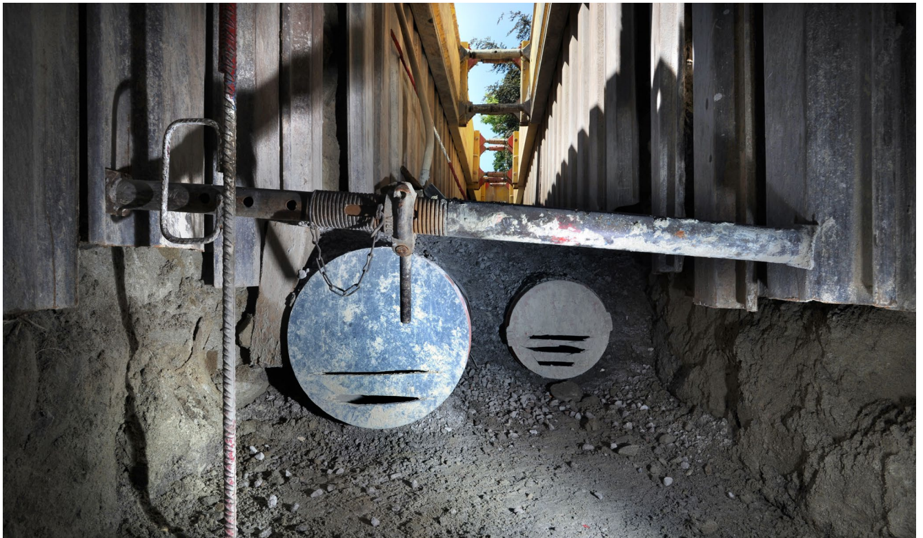
Kanalansierungsbaustelle in Lausanne
