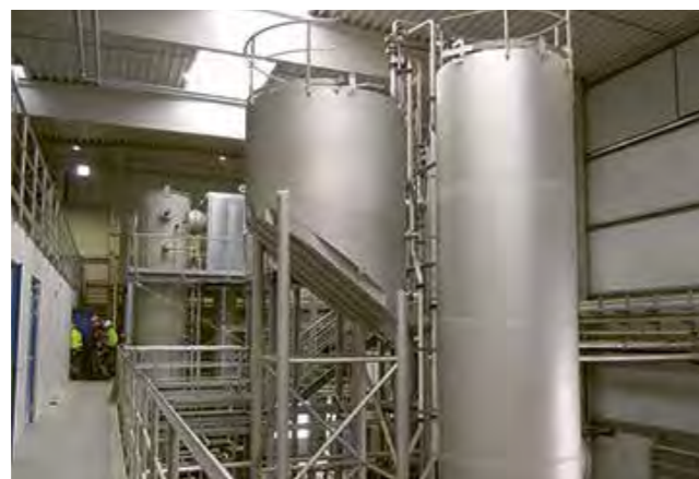
Im Bau befindliche Anlage zur Rückgewinnung von Nährstoffen in Form von Struvit (links: Fällungsreaktor für Struvit; rechts: Settler (für die Sedimentation der Struvitkristalle); Standort: Kläranlage Braunschweig (links außen)
