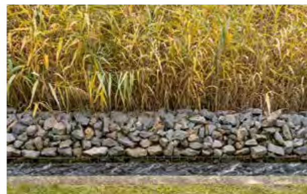
Retentionsboden zur Reinigung von Regenwasser in Berlin-Adlershof
