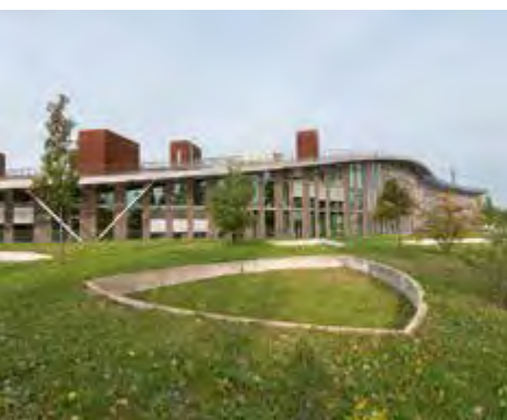
Dachbegrünung auf Büro- und Produktionsgebäude in Berlin-Adlershof
