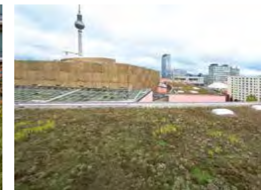
Dachbegrünung auf Einkaufszentrum am Alexanderplatz, Berlin
