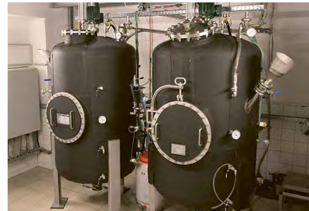
Versuchsreaktoren für die Thermo-Druckhydrolyse von Klärschlamm (rechts)
