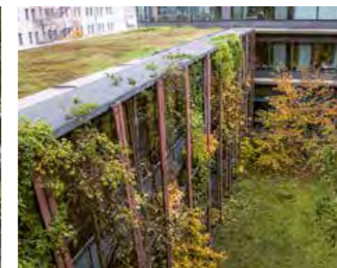
Fassadenbegrünung als Element der Gebäudekühlung, Institutgebäude der Humboldt Universität zu Berlin
