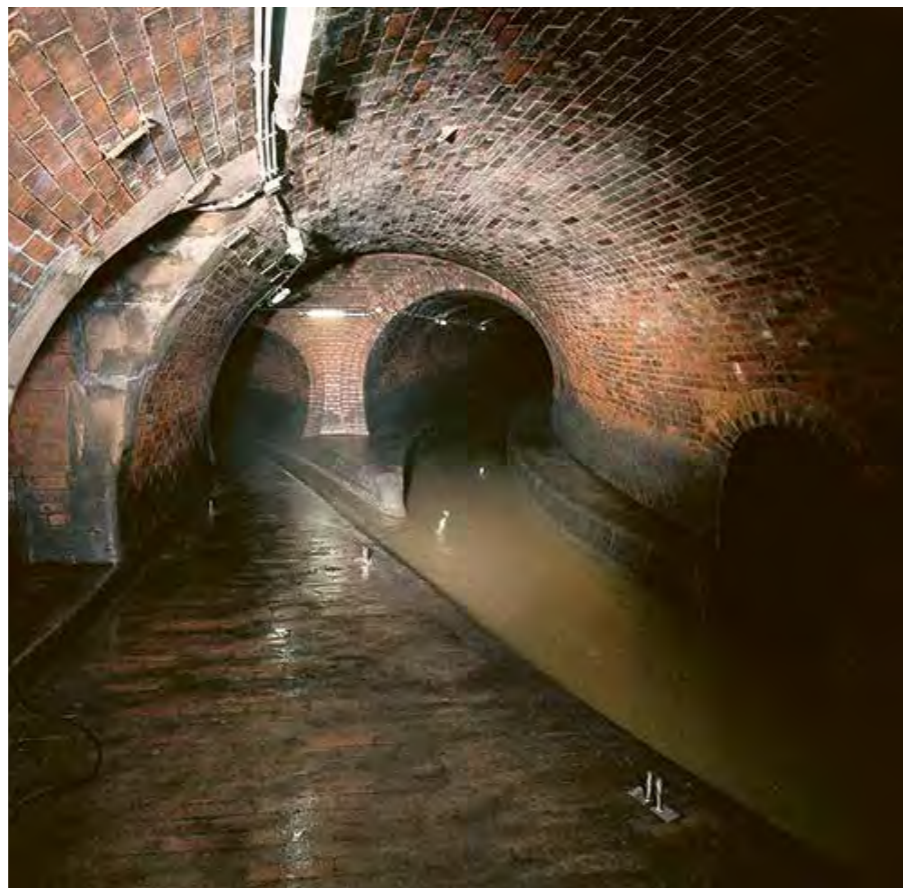
Blick in Mischwasserkanalisation, Berlin
