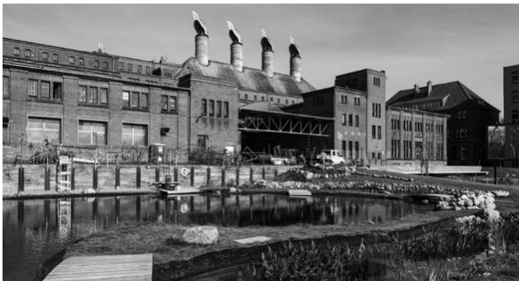
Regenwassergespeicher Teich an der Berliner Mälzfabrik
