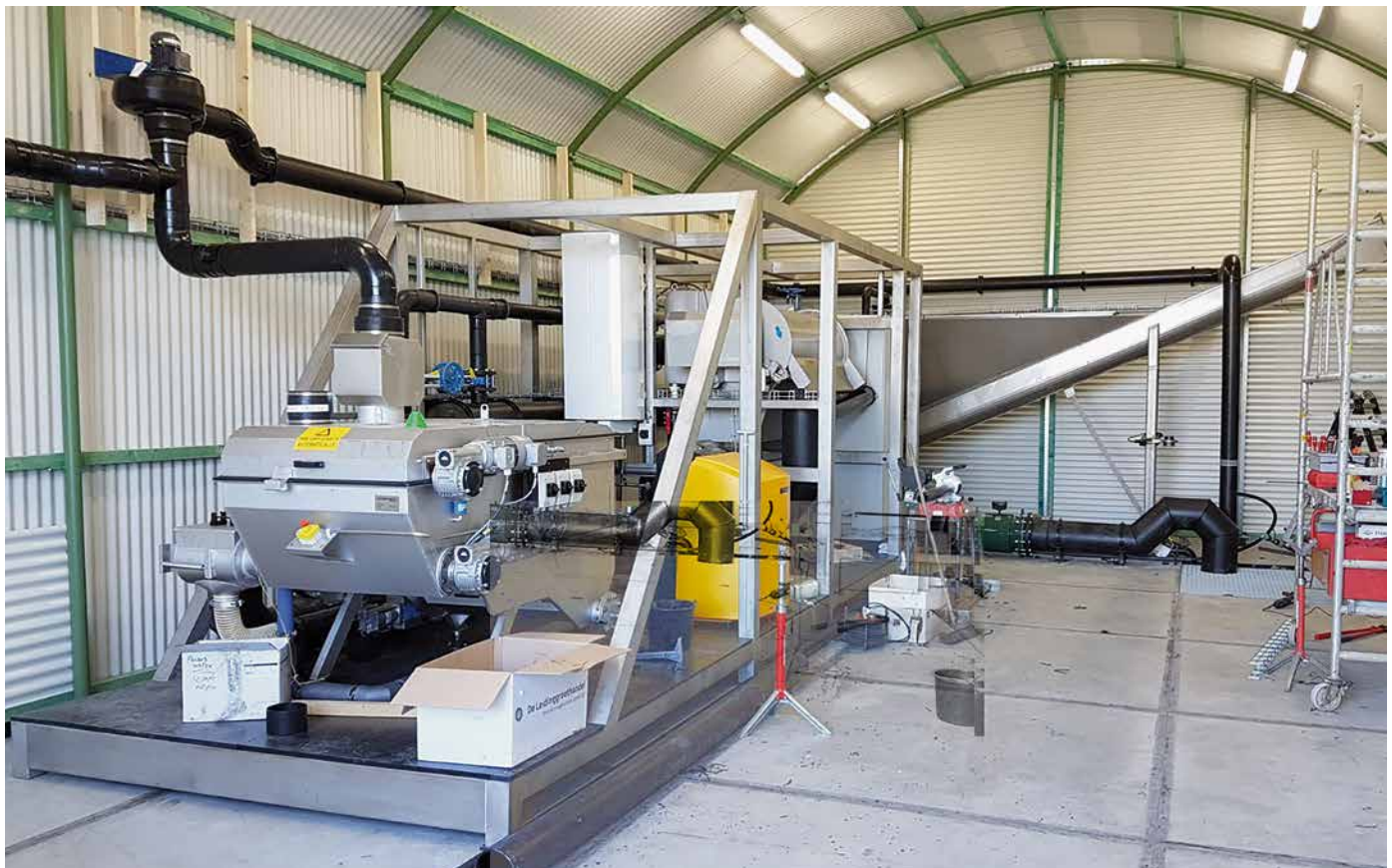
Rückgewinnung von Cellulose auf dem Klärwerk Geestmerambacht
