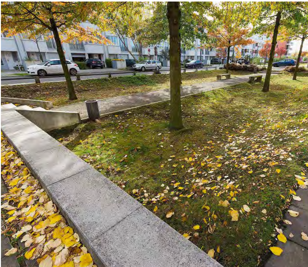
Maßnahmen der Regenwasserbewirtschaftung mit hoher Freiraumqualität: Baummulden an der Rummelsburger Bucht
