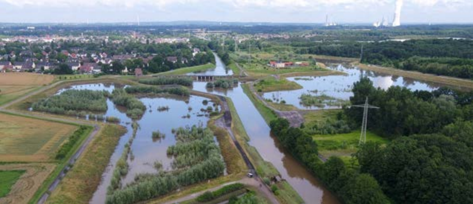
Bei Starkregen dienen die Emscher-Auen als Retentionsräume und bieten damit einen Hochwasserschutz für die dahinter liegenden Städte Herne, Gelsenkirchen, Essen, Oberhausen und Dinslaken | Quelle: EMSCHERGENOSSENSCHAFT/LIPPEVERBAND
