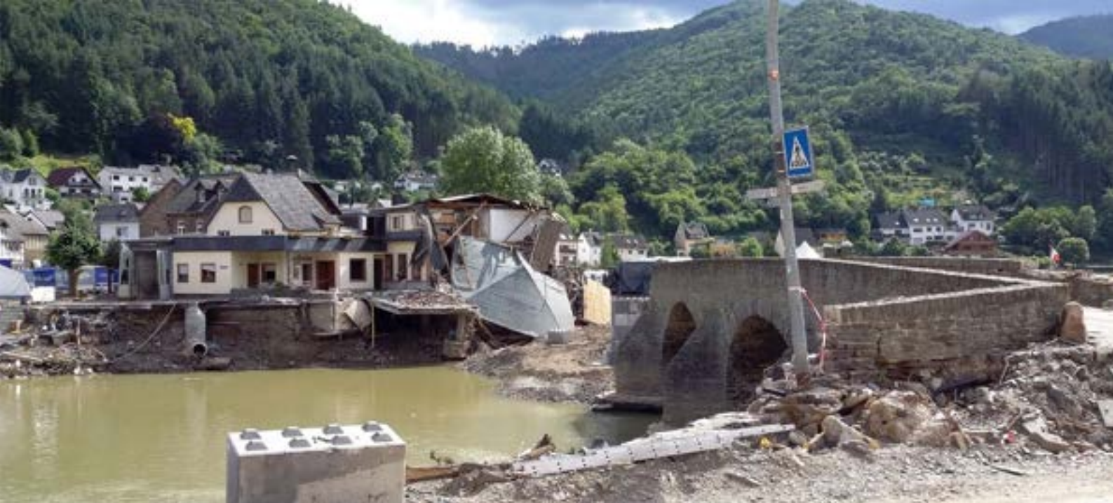
In der Nacht zum 15. Juli 2021 trat die Ahr meterhoch über die Ufer und zerstörte die Nepomukbrücke bei Rech, wie hier im Bild zu sehen | Quelle: Fraunhofer FKIE/Ralf-Michael Vette
