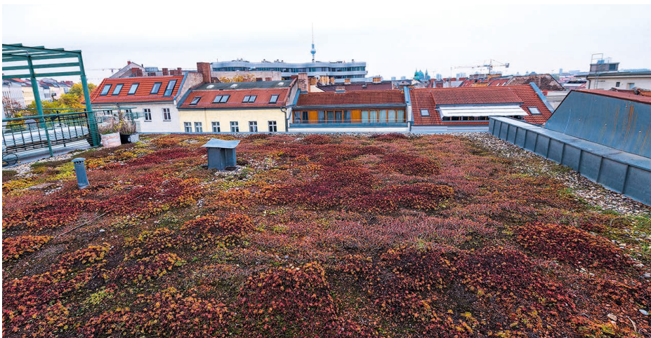
Extensive Dachbegrünung, Dach der WeiberWirtschaft eG, Berlin (Quelle: Andreas [FranzXaver] Süß)
