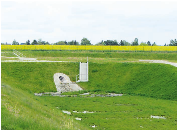
Regenrückhaltebecken, Flughafen BER, Berlin-Schönefeld (Quelle: Berliner Wasserbetriebe)
