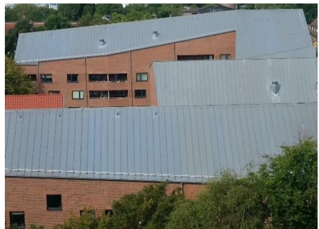
Großflächiges Metalldach aus Zinkblech (© OST)
