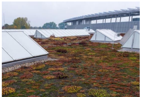
Extensive Dachbegrünung (© KWB/Andreas [FranzXaver] Süß)
