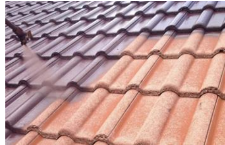
Beschichtung von Dachziegeln bei Sanierung (© KWB)
