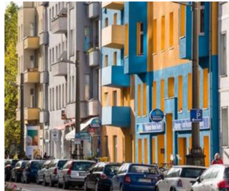
Gestrichene Fassaden an Gebäuden (© KWB/Andreas [FranzXaver] Süß)
