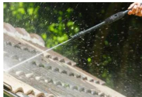
Mechanische Reinigung von Dachziegeln (© OST)
