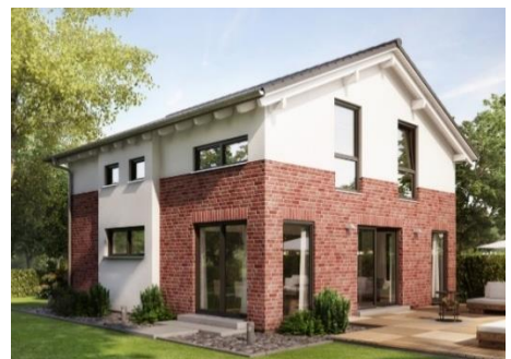
Klinkersteine an Fassaden (© KWB)
