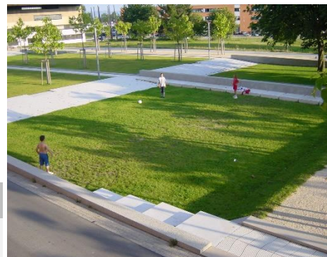
Multifunktionale Versickerungsfläche (© Dreiseitl)
