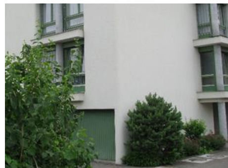
Bäume und Büsche an der Fassade (© OST)
