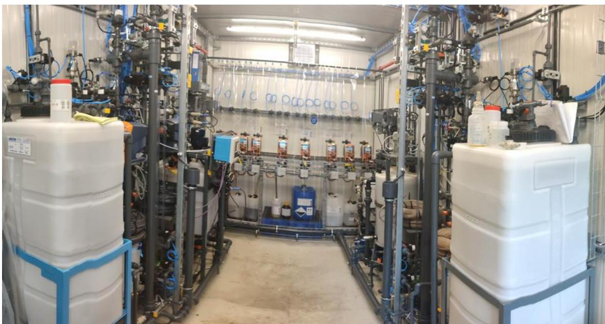
Abbildung 1.1-33 Innenaufnahme des 4-straßigen UF-Containers
