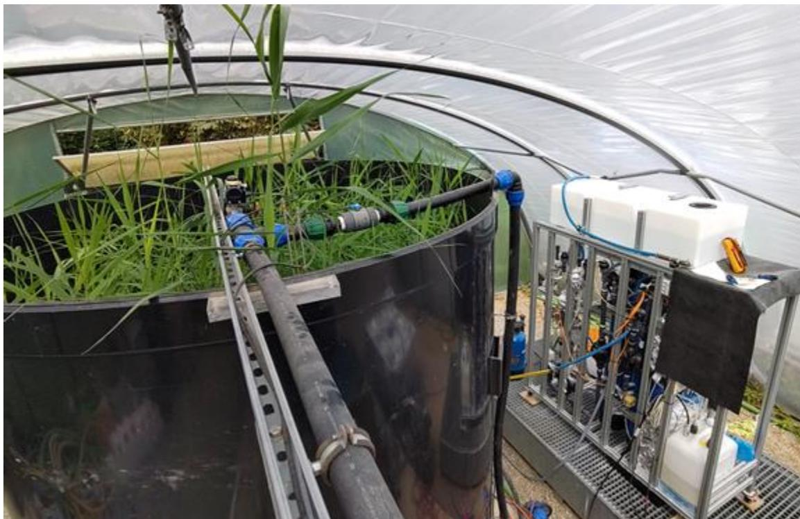
Abbildung 1.1-49: Pflanzenkläranlage (links, eine von zwei Filtersäulen) sowie Chlorerzeugung und Desinfektionsanlage (rechts).
