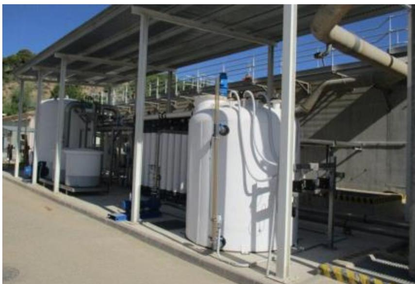
Abbildung 1.4-9: Umsetzung der Membranfiltrationsstufe auf der Kläranlage Caravaca de la Cruz
