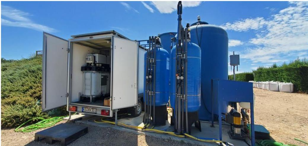
Abbildung 1.4-13: Anlage zur Desinfektion von Abläufen naturnaher Abwasseraufbereitungssystem
