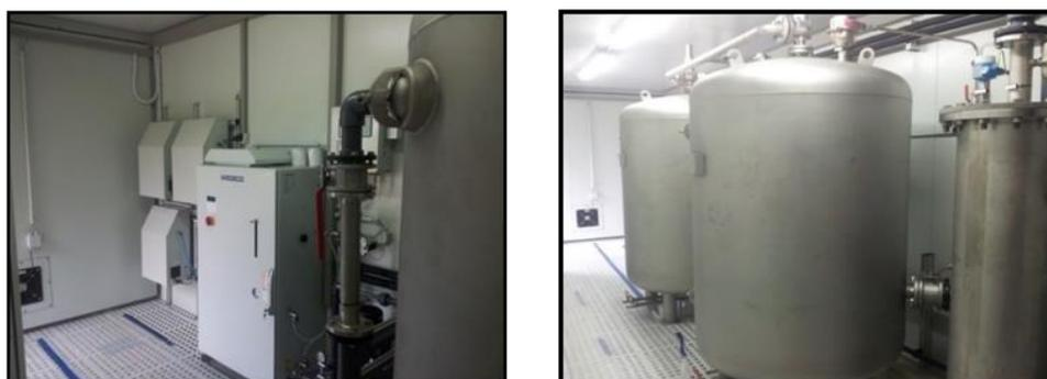
Abbildung 1.1-4: Drei Sauerstoffkonzentratoren und der Ozonerzeuger (links); zwei  $2 \text{ m}^3$ -Reaktoren und Entgasungstank (rechts).
