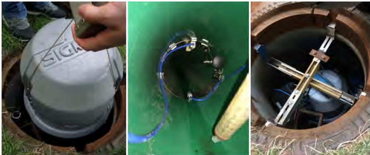
Abbildung 9: Installation von Probenehmer und Durchflussmessung im Testgebiet A
