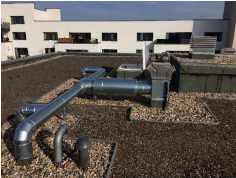
Abbildung 57: Dachaufbauten aus verzinkten Rohren in Testgebiet B
