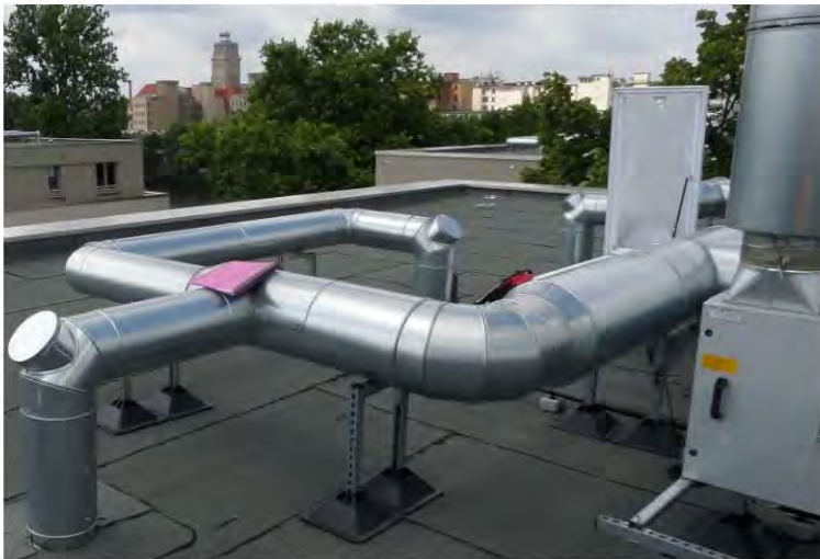
Abbildung 55: Dachaufbauten aus verzinkten Rohren in Testgebiet A
