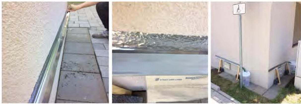
Abbildung 7: Installation der Fassadenrinnen im Testgebiet A
