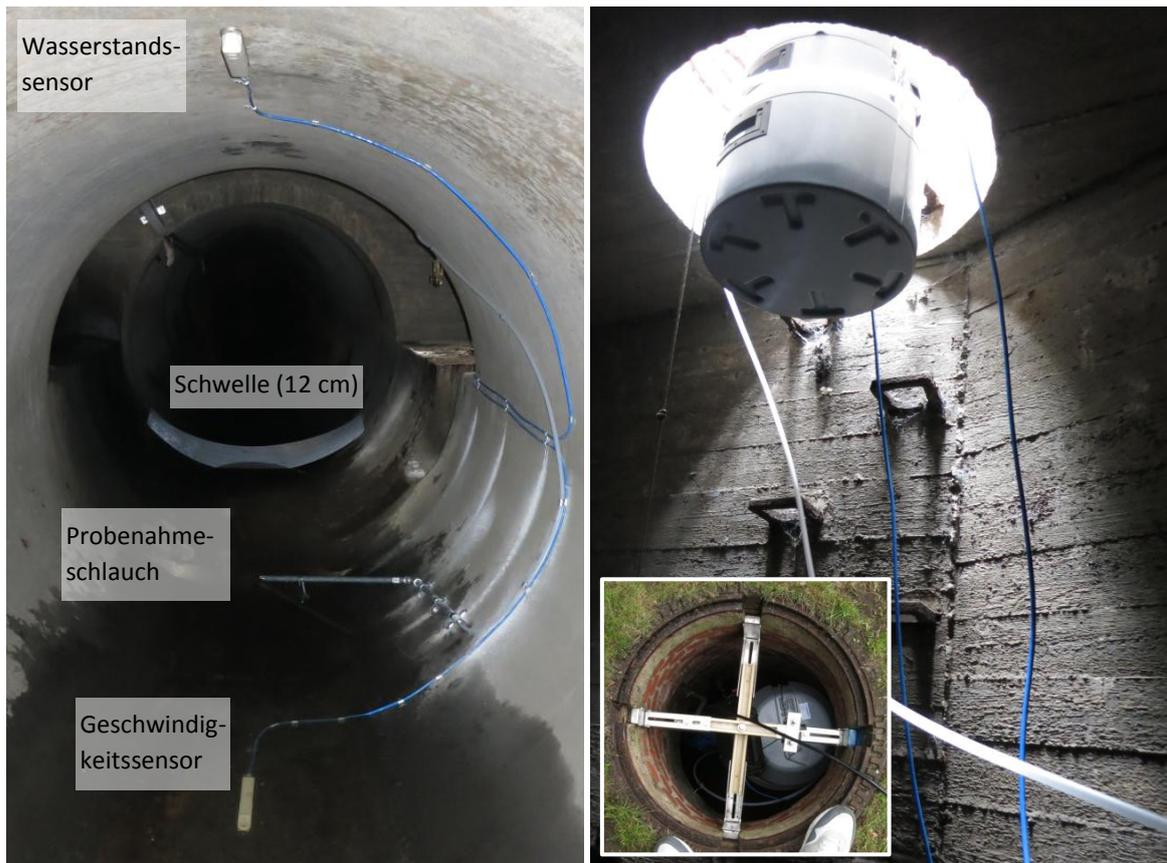
**Abbildung 12:** Typische Installation von Sensoren und in den Schacht gehängtem Probenehmer
