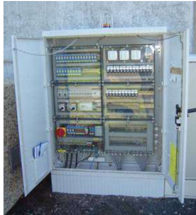
Abbildung 7: SPS Siemens S7 – 200 im Außenbereich
