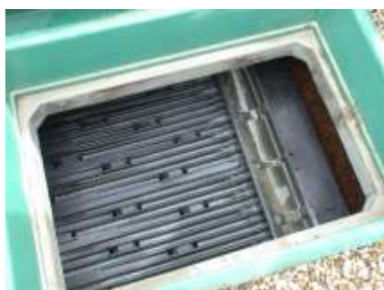
Abbildung 28: Abwasser-Verteilungssystem des Ecoflex™ Biofilters
