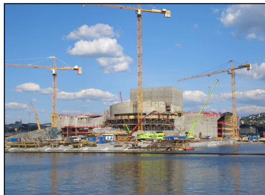
Construction site 2005 (Copyright Statsbygg)
