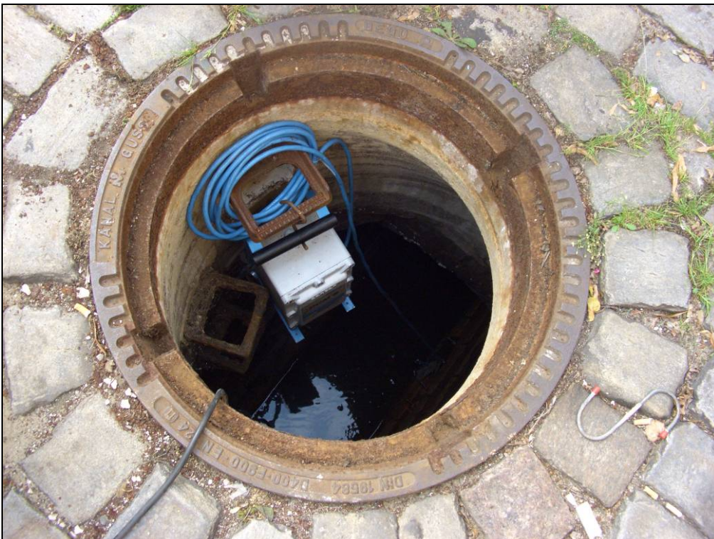
Schacht 15151.312 nach Einbau des Durchfluss-Messgerätes
