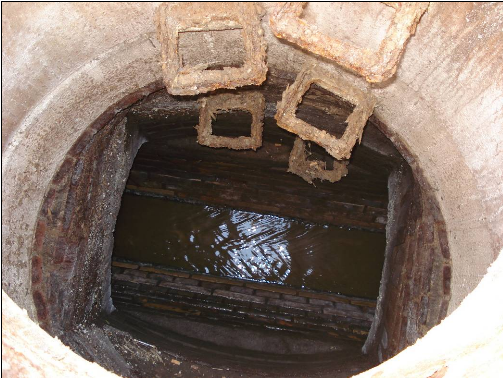
Schacht 15151.312 vor Einbau der Messgeräte
