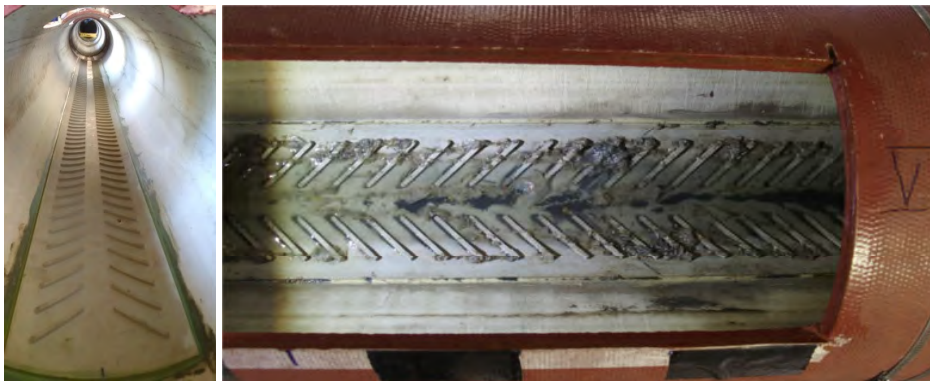
Abbildung 3: Eingebaute Oberflächenstruktur in die Kanalforschungsanlage der BWB [BWB]
