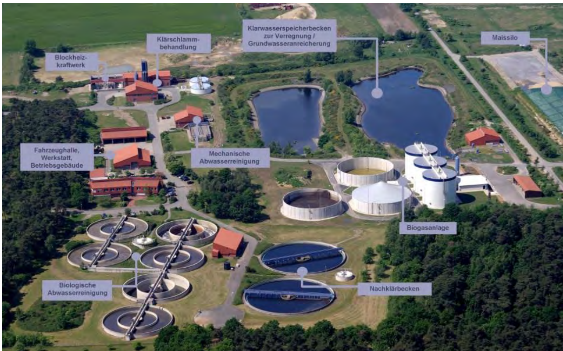
Abbildung 2: Luftbild der Kläranlage in Wolfsburg (mit freundlicher Genehmigung der Wolfsburger Entwässerungsbetriebe)
