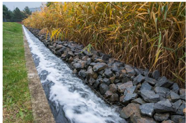
Retentionsbodenfilter Adlershof (Foto: Andreas Süß)
