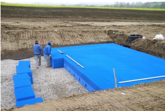
Kunststoffkörper beim Bau einer Rigole (Foto: IPS)
