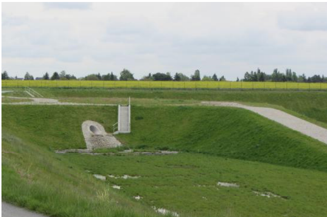
Regenrückhaltebecken im Business Park Berlin-Bohnsdorf (Foto: BWB)
