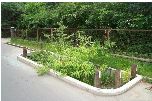
Mulden-Rigolen-Tiefbeet in Birkenstein, Brandenburg (Foto: Sieker)
