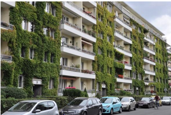
Abbildung 8: Fassadenbegrünung eines Wohngebäudes in Berlin-Schöneberg (Foto: HS NB)
