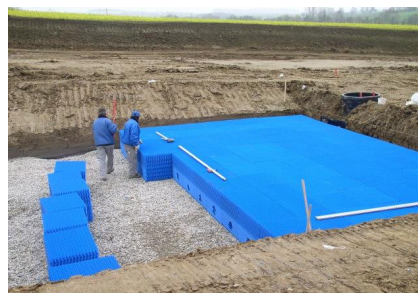
Bau einer Füllkörperrigole (Foto: Sieker)
