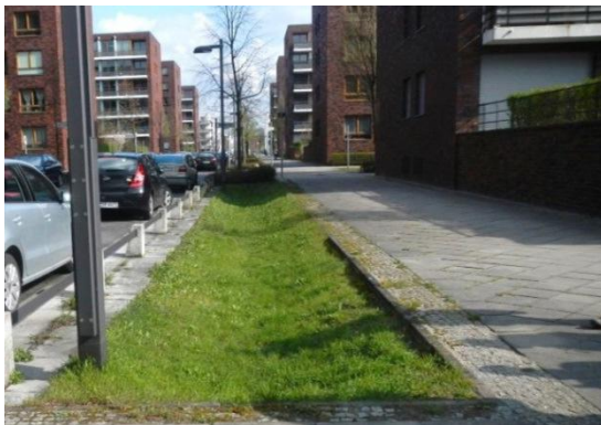
Straßen- und Gehwegentwässerung (Foto: IPS)
