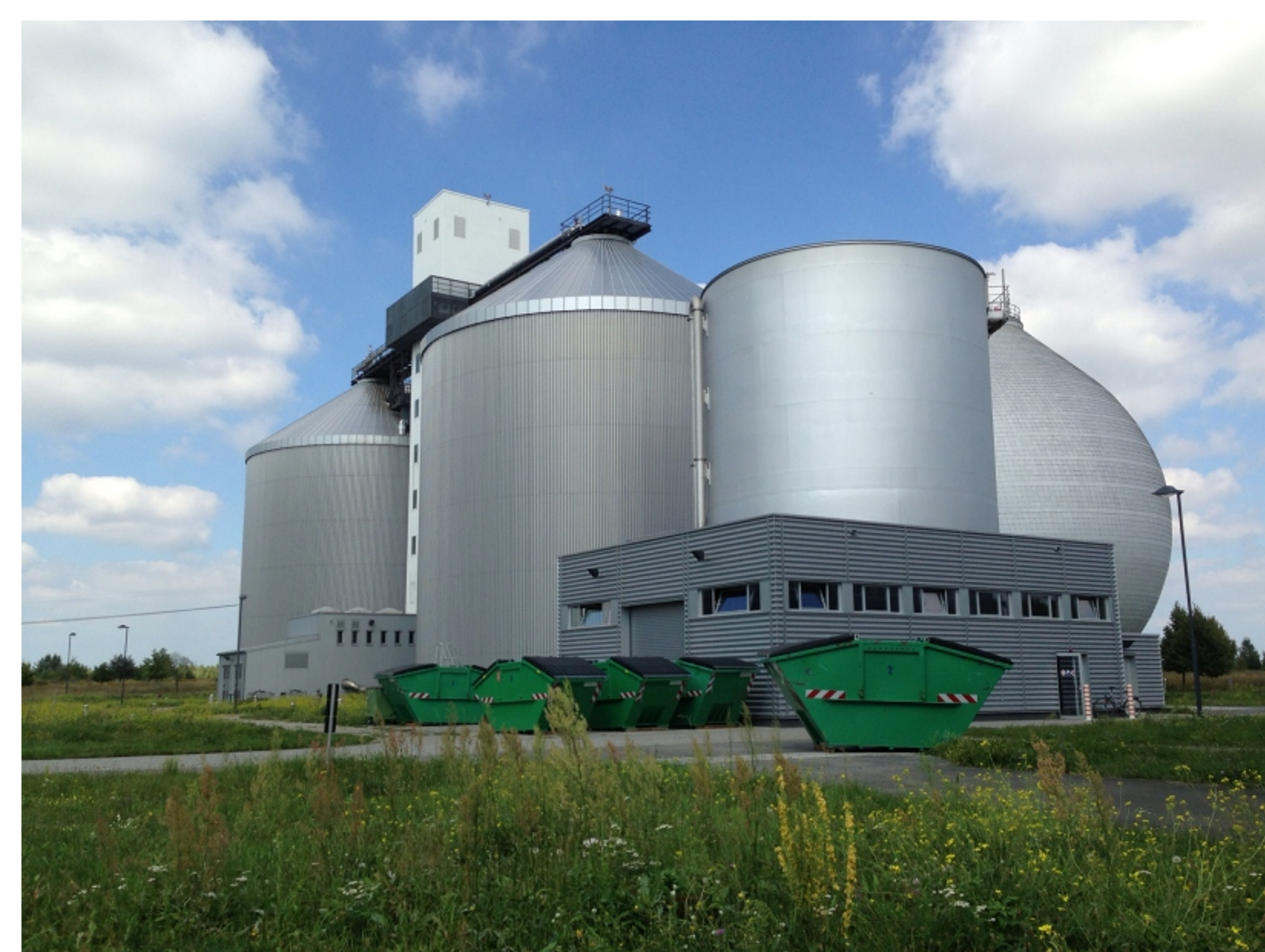
MAP-Anlage der Berliner Wasserbetriebe
