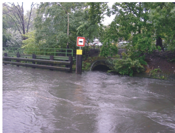
Mischwassereinleitung ins Gewässer
