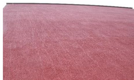
Schlagregen an einem Gebäude (© OST)
