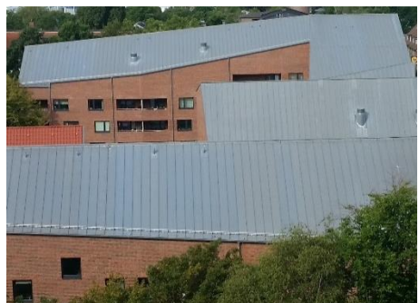
Großflächiges Metalldach aus Zinkblech (© OST)
