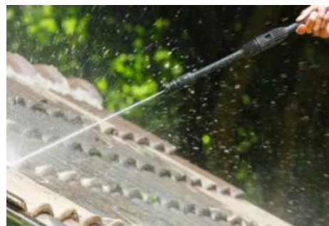
Mechanische Reinigung von Dachziegeln (© OST)
