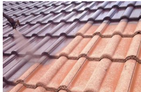
Beschichtung von Dachziegeln bei Sanierung (© KWB)
